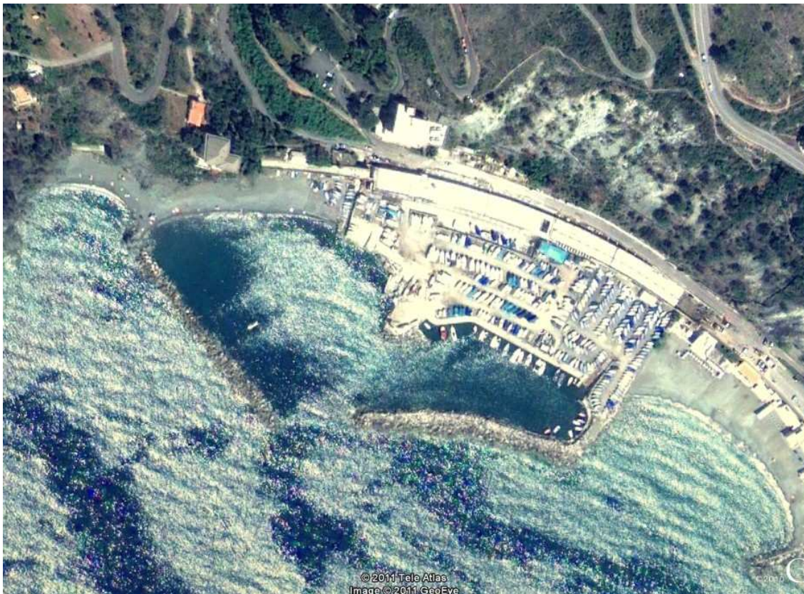
Fig. 1: Foto aerea dell'area nautica a cavallo del confine intercomunale
